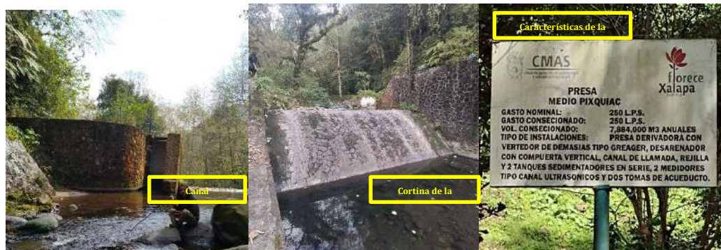
Figura 2 Presa derivadora Medio Pixquiac y sus características
