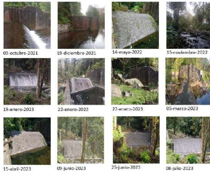
Algunos momentos en lo que se observó, o no, flujo a la altura de la presa
