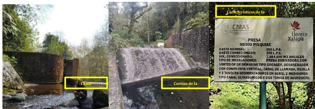
Figura 2 Presa derivadora Medio Pixquiac y sus características
