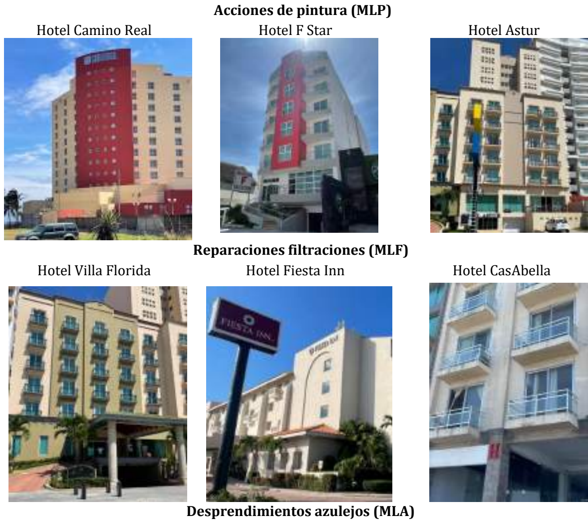
Figura 9 Casos de deterioro leve
