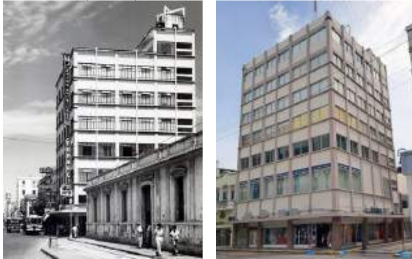
Figura 2 Edificio Pazos (ca. 1940), con alteraciones menores
